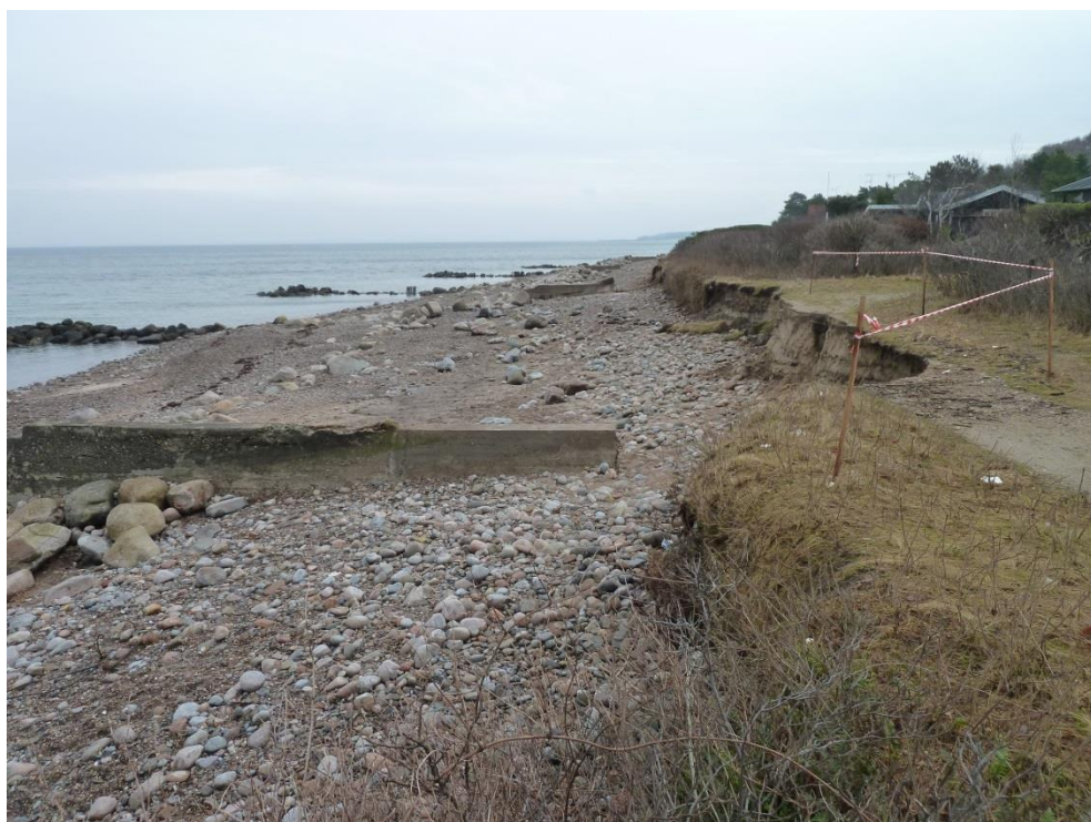
Figur 2.26 Fotos efter Stormen Bodil d. 6.12.2013, som medførte ekstremt højvande på 1,9 m langs Sjællands Nordkyst. Øverst: Jævnt fordelt akut erosion langs klitrækken NØ for Liseleje. Nederst: Skrænterosion langs Villingebækstien, bemærk at hølften ikke har haft nogen virkning.
