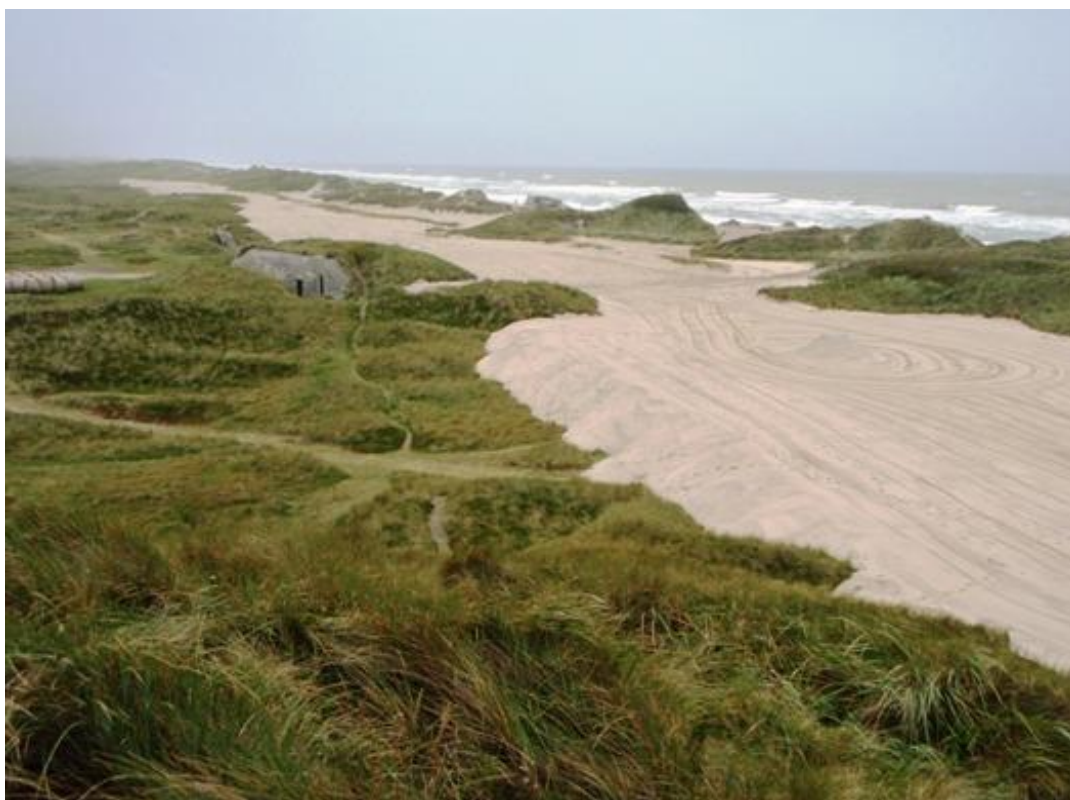
Figur 3.20 Klitforstærkning ved Krylen, Vestkysten. Udført af KDI.
